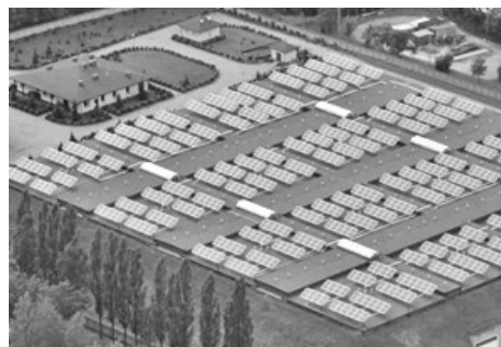
Rys.3. Elektrownia fotowoltaiczna w Rudzie Śląskiej [8]
