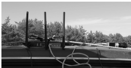
Rys. 4. Stanowisko mobilne z routerem WiFi i kamerą
