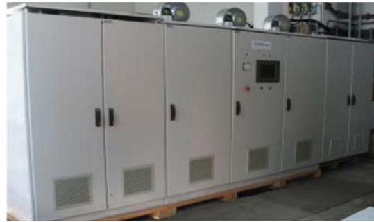
Rys. 7. Widok wielopoziomowego falownika średniego napięcia AC/AC.
