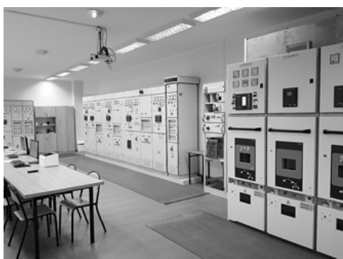
Rys. 1. Model okrętowego systemu elektroenergetycznego typu IT [1]
