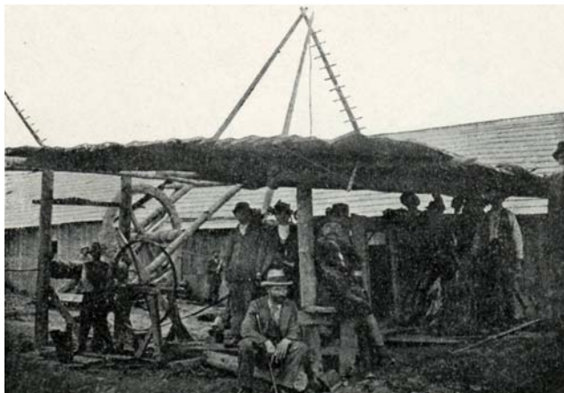
Fot. 2. Ręczny kołowrót wydobywczy w kopalni w Borysławiu, (źródło: Die Gross-Industrie Oesterreichs. Festgabe zum glorreichen 50-jähr. Regierungsjubiläum Seiner Majestät des Kaisers Franz Josef I , t. I, Wien 1898, s. 330)
