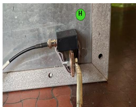
Rys. 9. Umieszczenie sensora HFCT na przewodzie wyrównawczym PE rozdzielnicy
