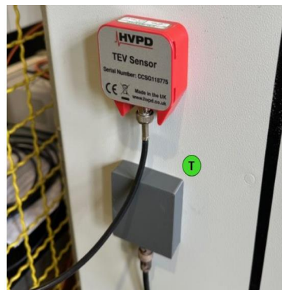
Rys. 8. Widok sensorów TEV (czerwony HVPD, szary ITR) na ścianie rozdzielnicy
